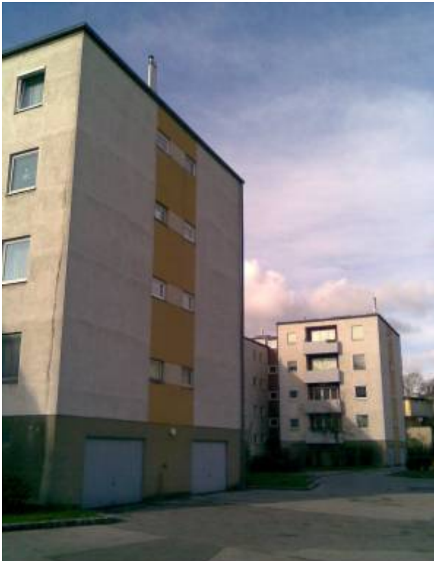
Neu gedämmte Fassade und neue Balkons, Dez. 2009
