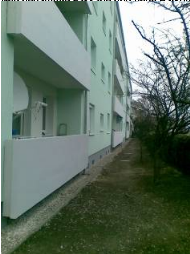
Neu gedämmte Fassade und neue Balkons, Dez. 2009
